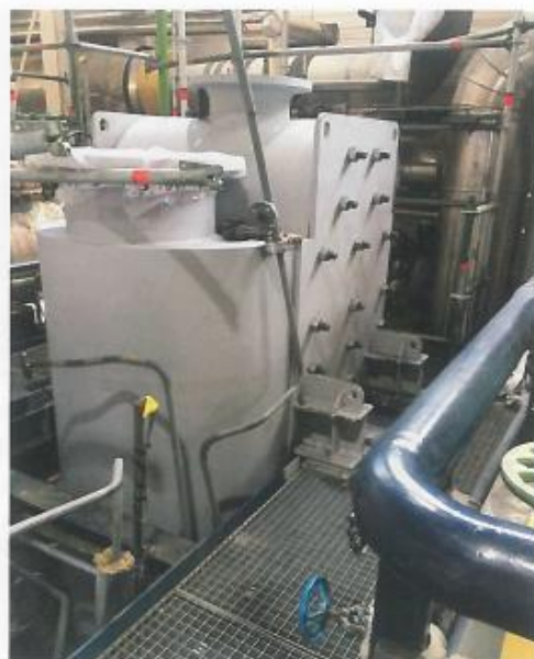
Bild 5. Einbau eines Hybrid Tubular Plattenwärmeübertragers in einer Müllverbrennungsanlage
