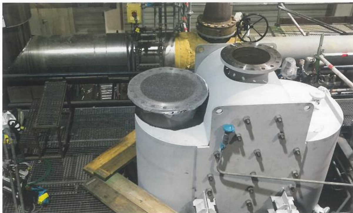
Eingebauter Hybrid Tubular Wärmeübertrager für die Heißwasserbereitung in Heizkraftwerken
